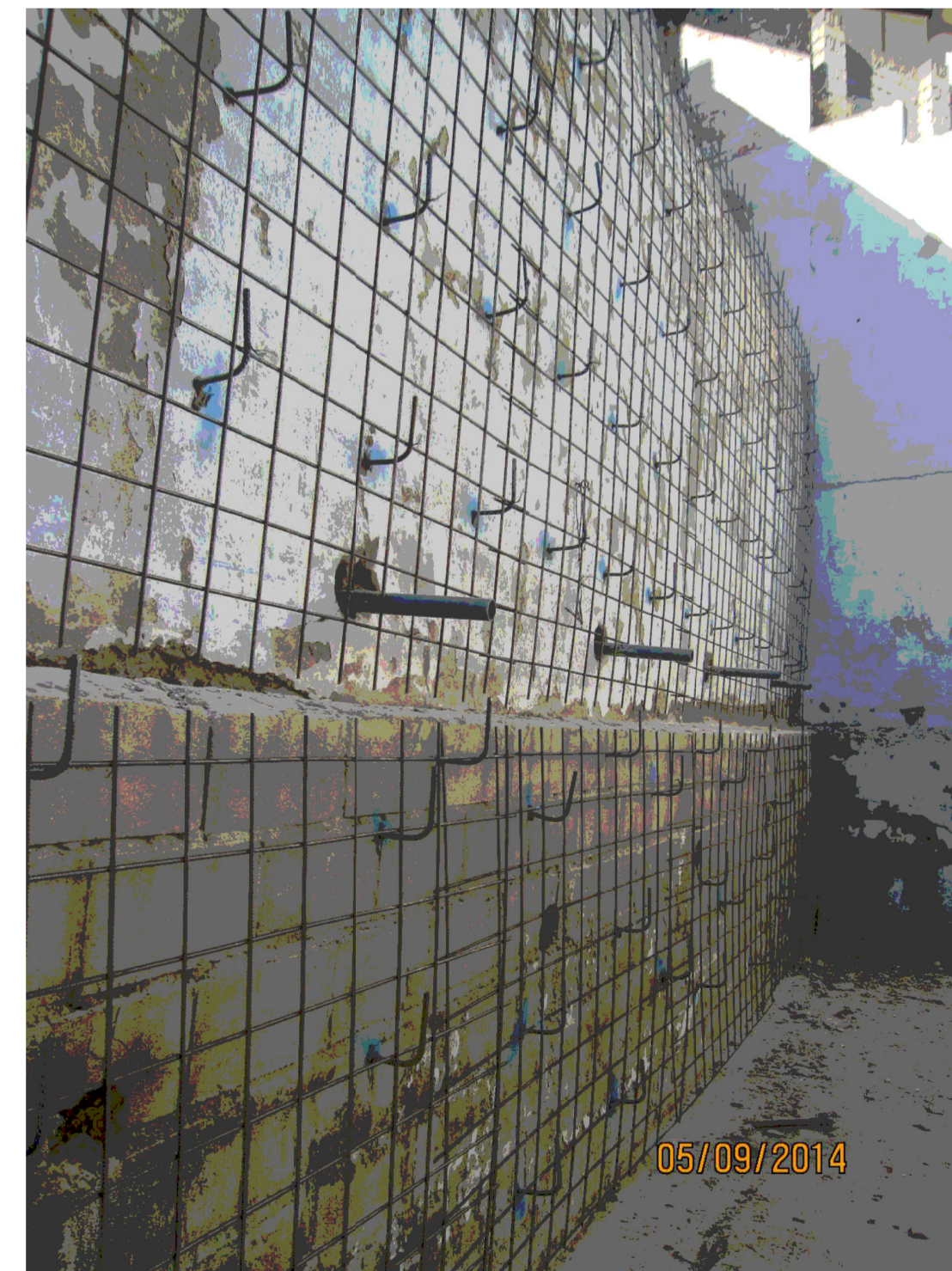
EJEMPLO EJECUCIÓN ARMADURA ANTES DEL GUNITADO
