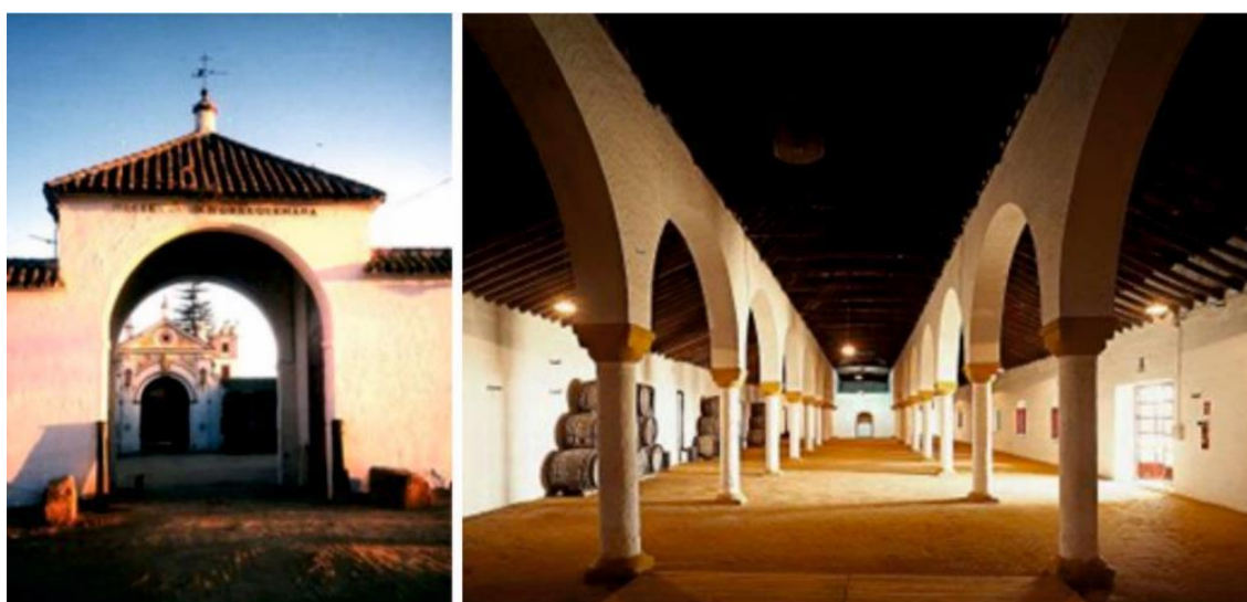
Vista general de la portada y el Interior de la Nave.
