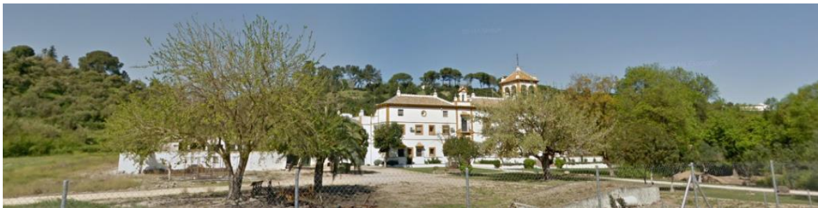
Vista general de la Hacienda desde la calle José Eloy García Brioso.
