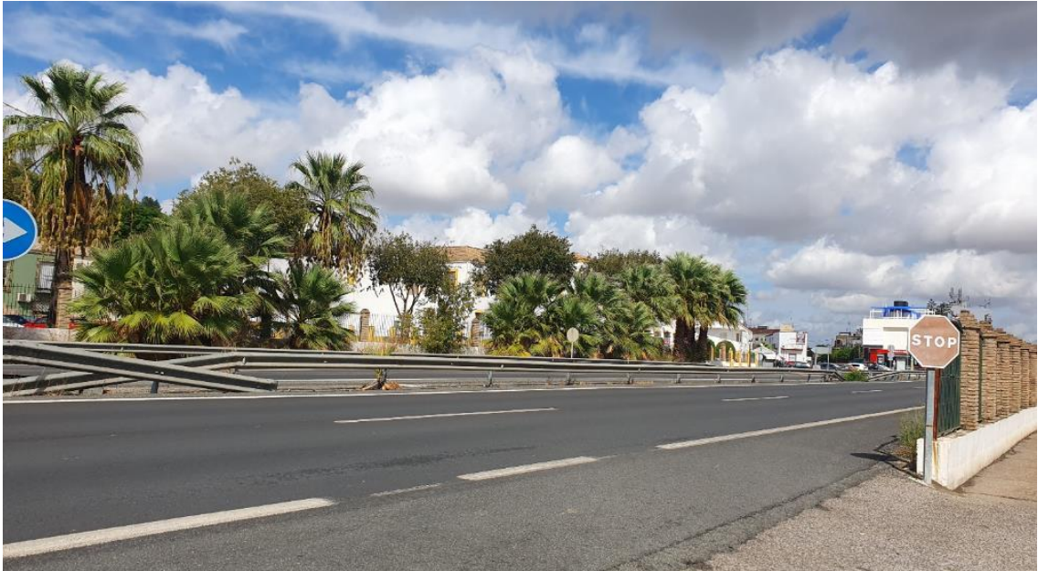
Vistas de la autovía a-8058 a su paso por el municipio.
