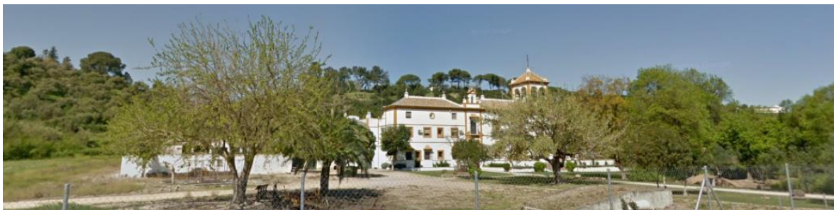
Vista general de la Hacienda desde la calle José Eloy García Brioso.
