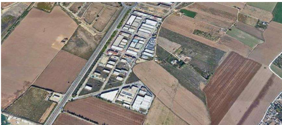
Vista aéreo polígono industrial Guadalquivir al sur del T.M. Fuente Google Earth
