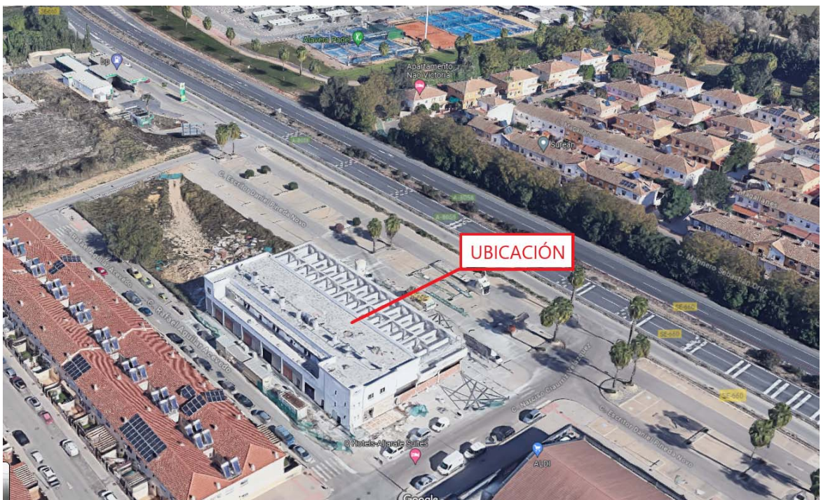
Vista aérea del local
