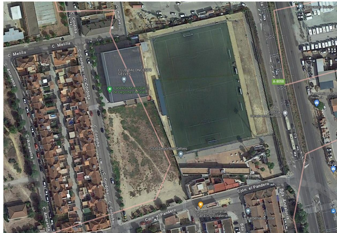
Foto aérea del Ámbito de la Modificación.
