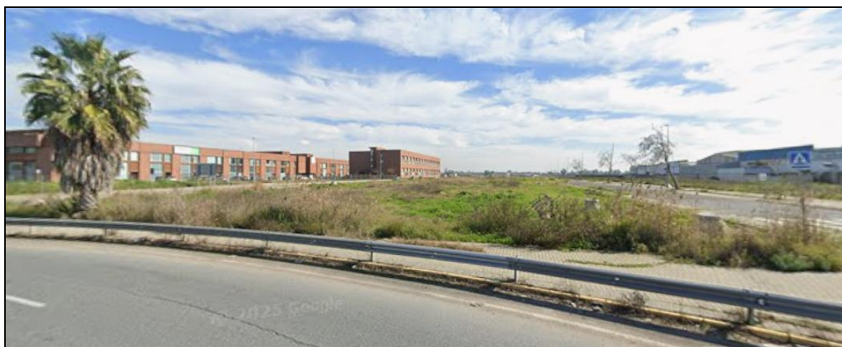
Figura 2: Vista general de la parcela desde la rotonda de la vía A-8058
