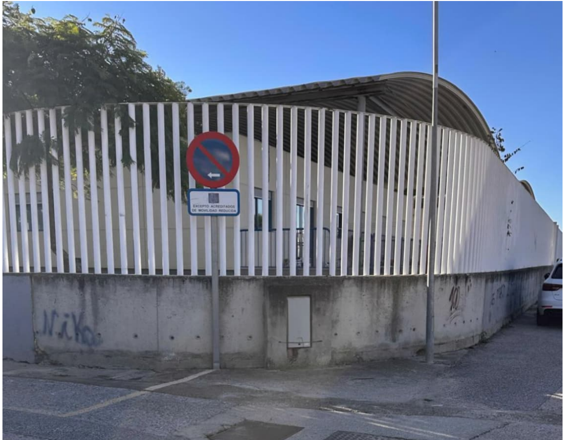
Cerramiento del CEIP
