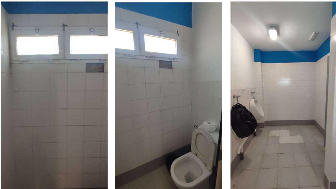
Fotografías del estado actual de los aseos a intervenir.
