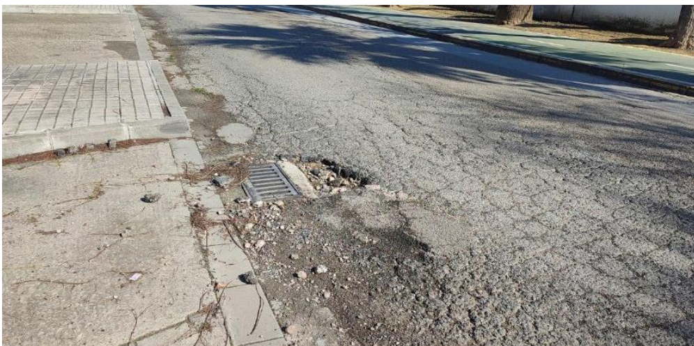
Fig.03 Distintas fotografías del estado de conservación de la capa de rodadura de las calles por donde discurre el actual carril bici y la ampliación proyectada.
