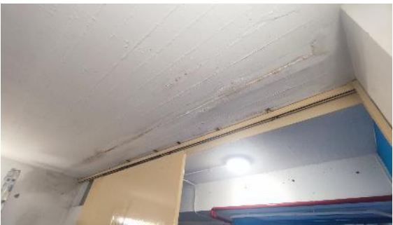
Fotografías de las filtraciones de agua detectadas en el interior del edificio.
