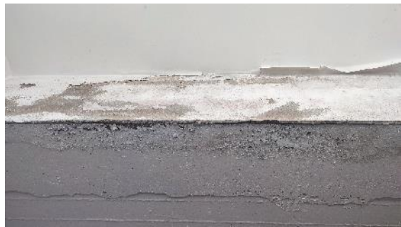
Fotografías de las filtraciones de agua detectadas en el interior del edificio.
